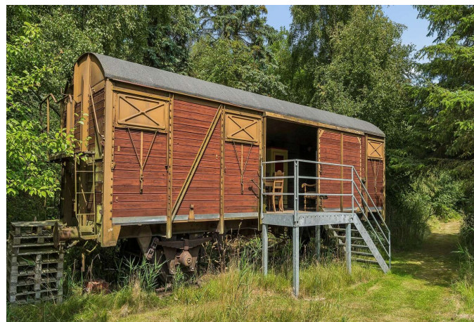
Togvogn som er renoveret
